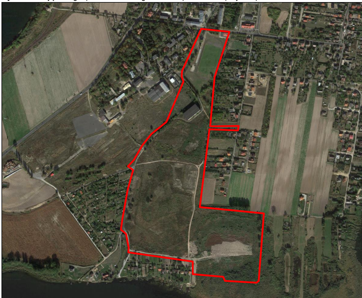
Ryc. 2. Istniejące zagospodarowania w granicach opracowania projektu planu
